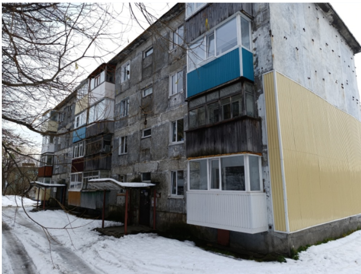
Общий вид здания:
