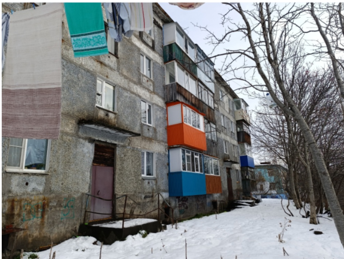
Общий вид здания:
