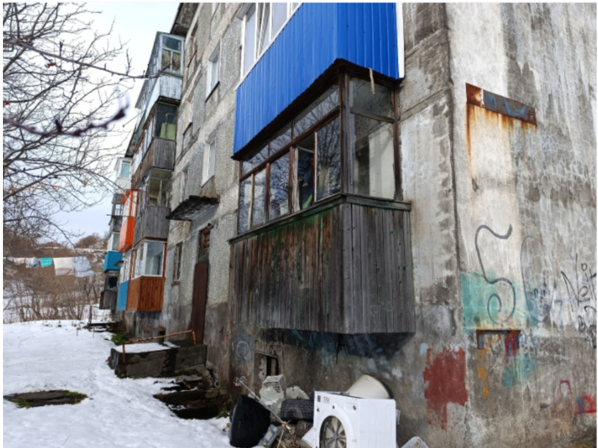
Общий вид здания:
