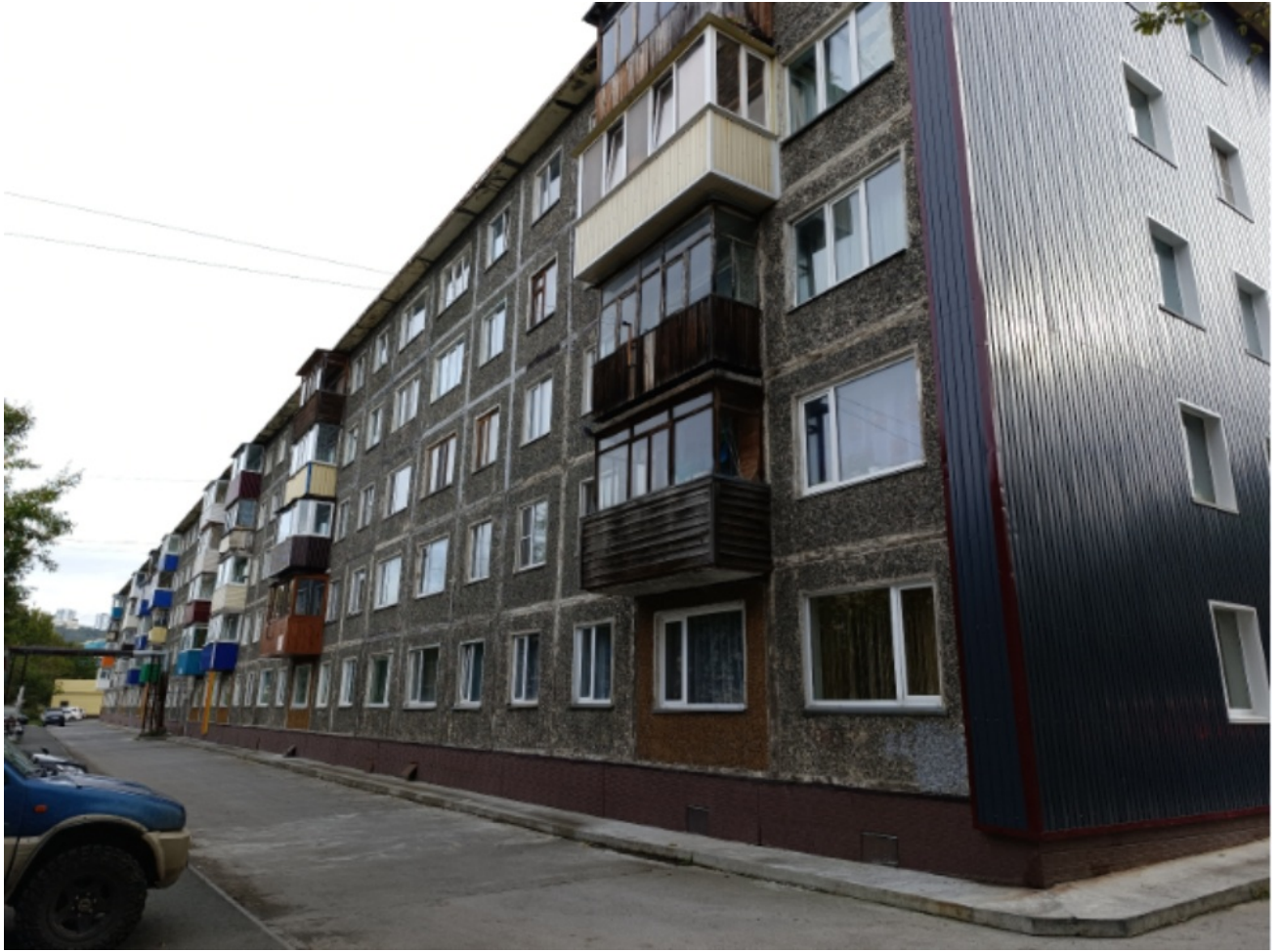
Общий вид здания:
