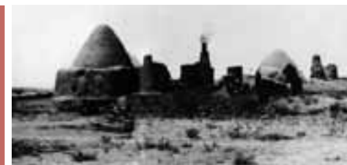
Простейшая установка для очистки сырой нефти. Иракский Курдистан. 1930 г.
